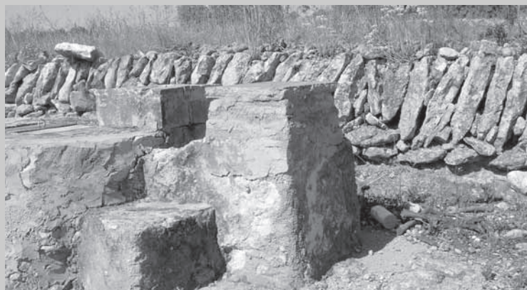
Cisterna amb pica
